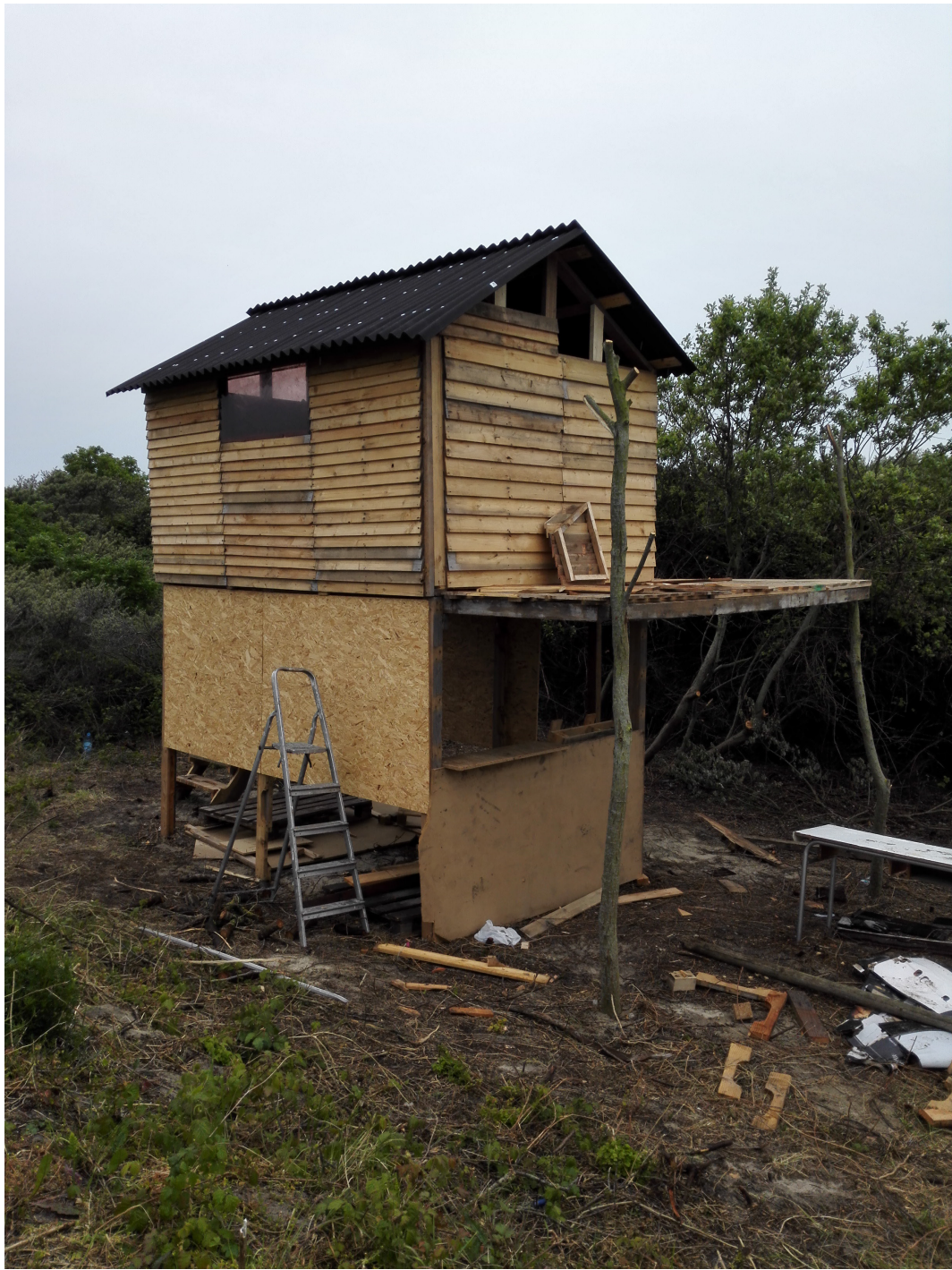
Auto-construction, New-Jungle de Calais, juin 2015. Photographie : Cyrille Hanappe
